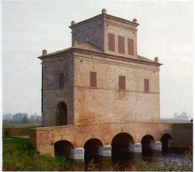
325. Mesola, Torre Abate. Questa grande chiavica a cinque luci scaricava al mare le acque dei territori più elevati della grande bonifica estense del Polesine di Ferrara (1564-1580).
