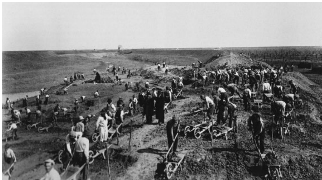
6. Scariolanti nei lavori al canale destra romagnolo.
