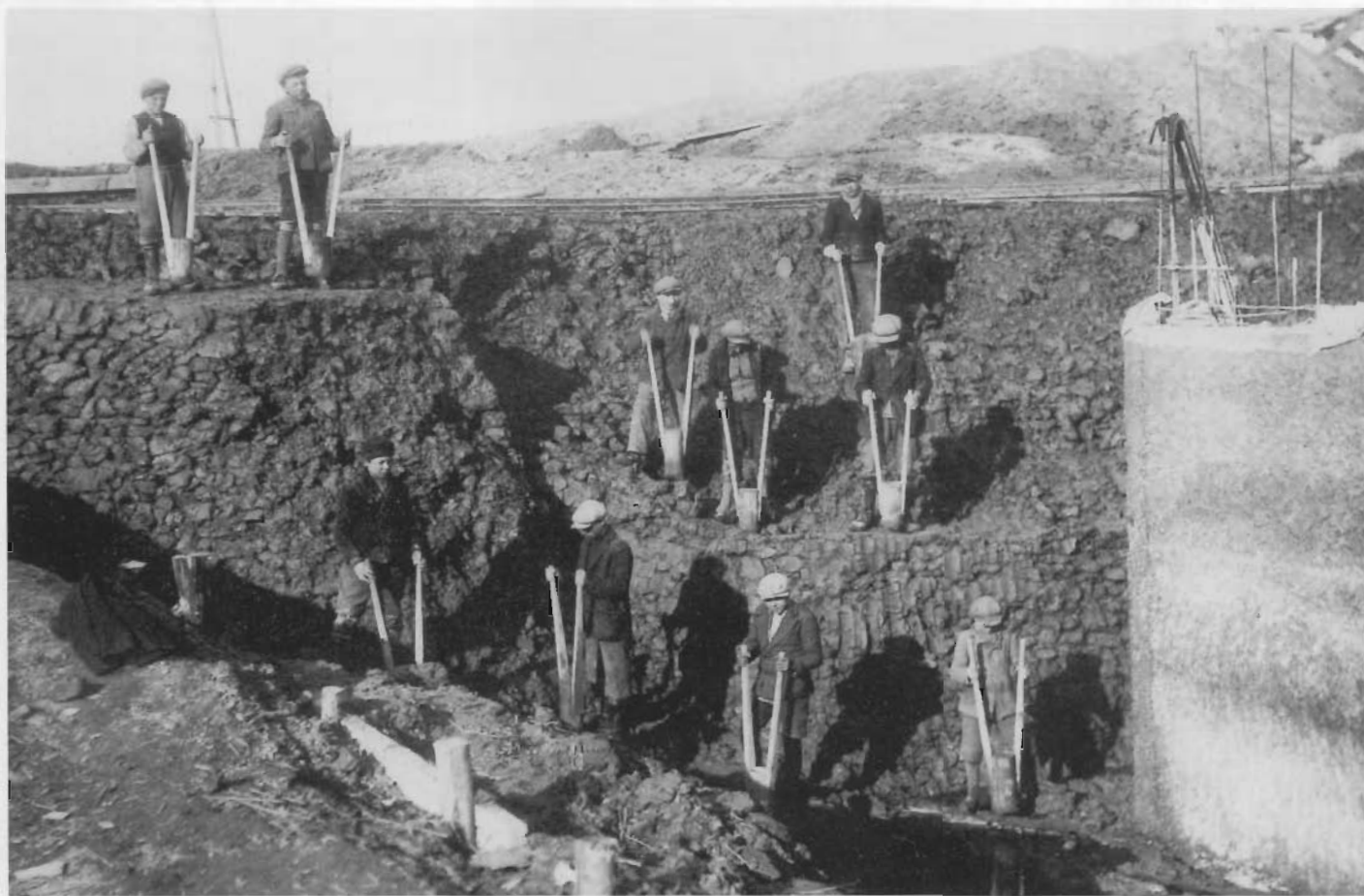
Lavori di costipamento del terreno, durante le opere di bonifica degli anni Trenta.
